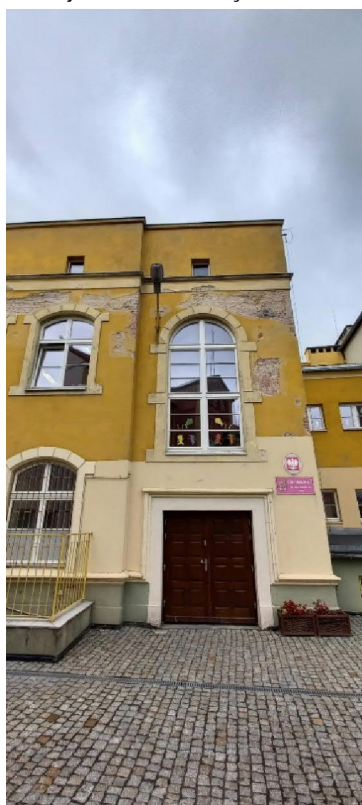
Widoczne ubytki w tynku na elewacjach, drzwi wejściowe oraz balustrady do renowacji.
