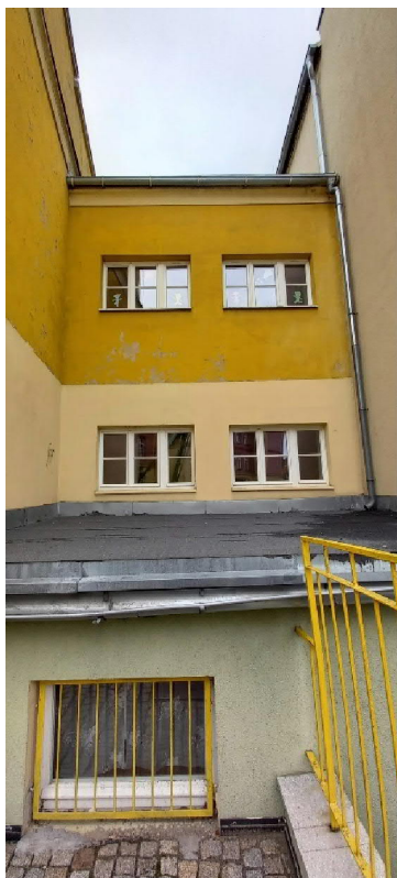
Drzwi do piwnicy do wymiany, balustrada i murek do renowacji.
