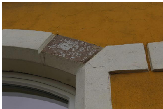
Ubytki w nadprożach i opaskach okiennych.
