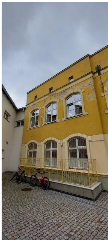
Widoczne ubytki w tynku na elewacjach, drzwi wejściowe oraz balustrady do renowacji.
